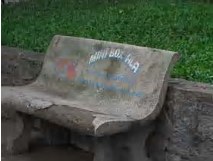
Foto 08- Detalhe bancos com danos aparentes. Município de Cambuí, Distrito Sede Praça da Matriz de Cambuí. Data: janeiro de 2006
