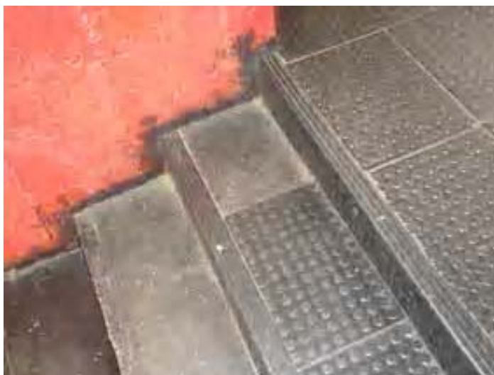
Foto 06- Detalhe piso anti- derrapante na escada central, interrompido em trechos do primeiro e segundo degrau. Município de Cambuí, Distrito Sede Edificação à Praça Coronel Justiniano, 164 - Centro. Data: janeiro de 2006
