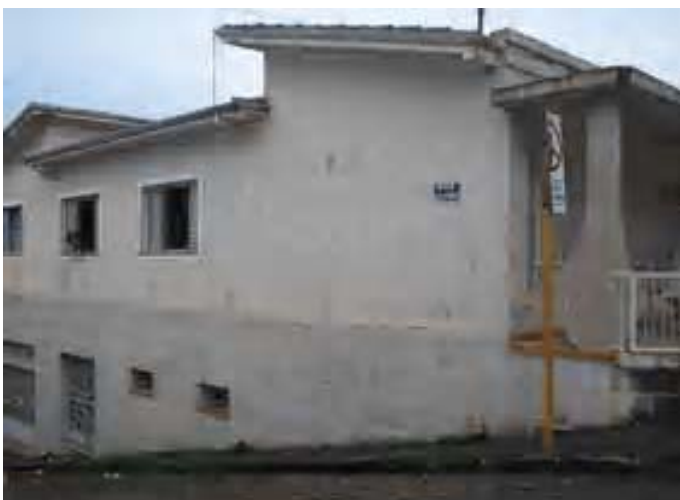
Foto 03- Isométrica fachada frontal e lateral esquerda. Município de Cambuí, Distrito Sede. Edificação à Rua Padre Caramuru, 345 Data: janeiro de 2006
