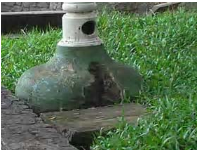
Foto 10- Detalhe base poste bastante danificado. Município de Cambuí, Distrito Sede. Praça da Matriz de Cambuí Data: janeiro de 2006
