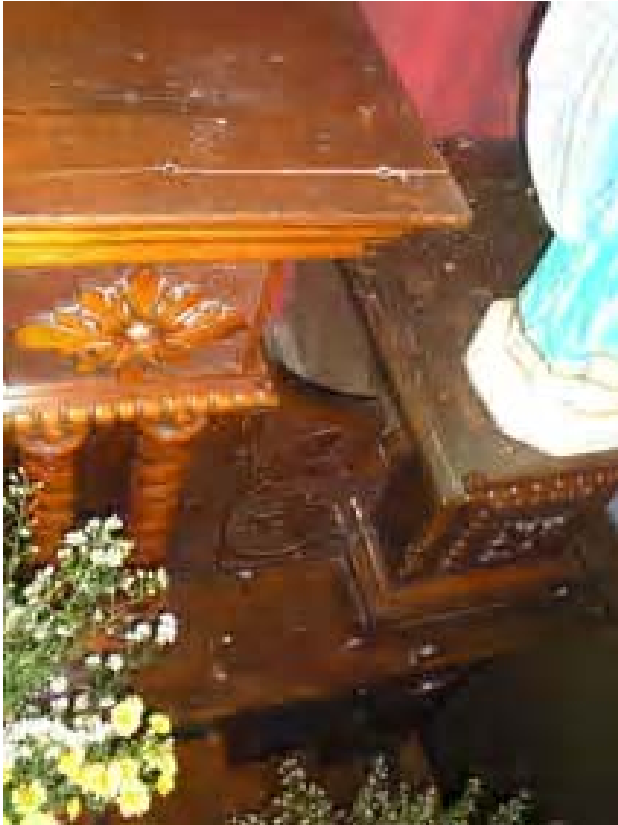
Foto 07- Detalhe danos, vista superiore altar. Município de Cambuí, Distrito Sede. Igreja Nossa Senhora do Carmo. Data: janeiro de 2006
