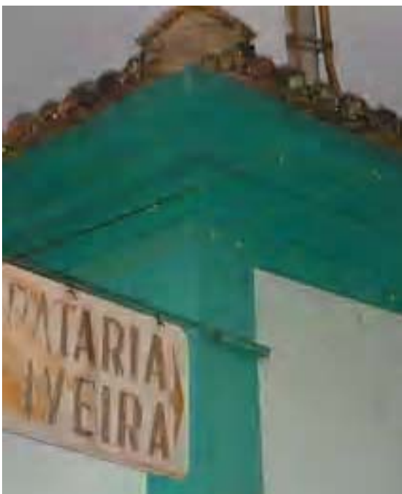
Foto 04- Detalhe cimalha cobertura. Município de Cambuí, Distrito Sede. Edificação à Rua Governador Valadares, 237. Data: janeiro de 2006
