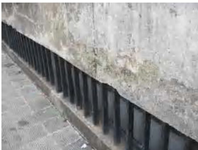
Foto 07- Detalhe quinas de concreto danificado e localizado na fachada frontal. Município de Cambuí, Distrito Sede Edificação à Praça Coronel Justiniano, 164 - Centro Data: janeiro de 2006
