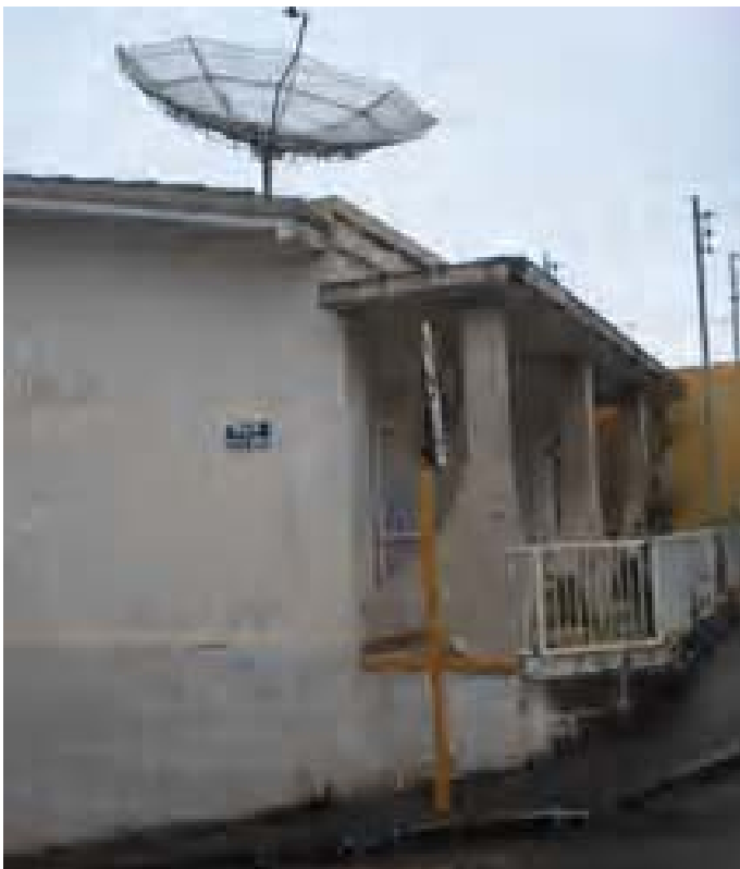
Foto 02- Isométrica fachada frontal e lateral esquerda. Município de Cambuí, Distrito Sede. Edificação à Rua Padre Caramuru, 345 Data: janeiro de 2006
