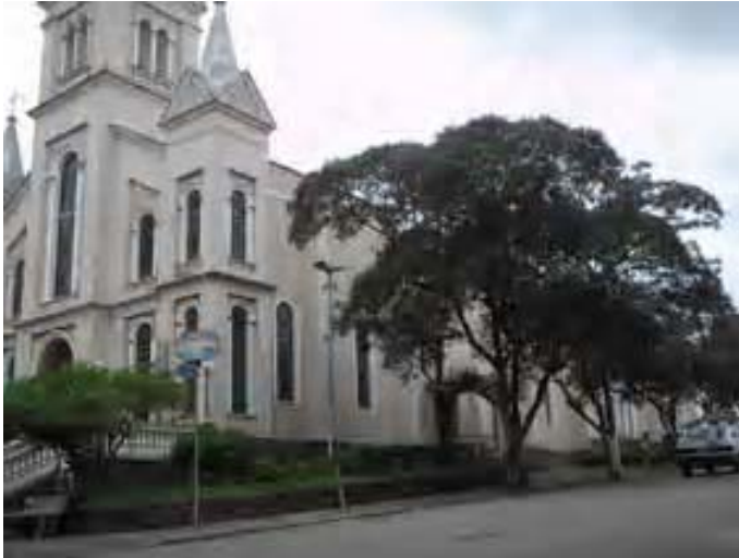
Foto 02- Isométrica lateral direita Igreja Nossa Senhora do Carmo. Município de Cambuí, Distrito Sede. Edificação à Praça Prof. Maximiniano Lambert, 149 Data: janeiro de 2006
