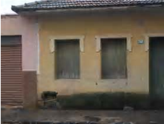
Foto 02- Detalhe fachada frontal com trecho danificado Município de Cambuí Distrito Sede Edificação à Rua Padre Caramuru, 383 Data: janeiro de 2006
