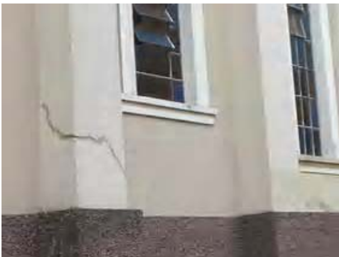
Foto 10- Detalhe trinca no pilar.
