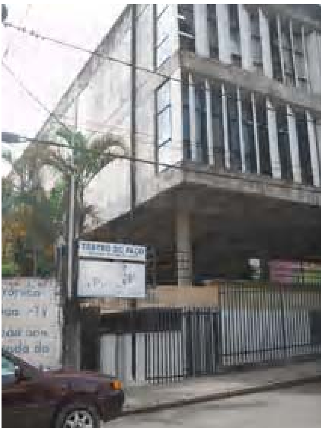
Foto 04- Isométrica fachada posterior e trecho fachada lateral esquerda. Município de Cambuí, Distrito Sede Edificação à Praça Coronel Justiniano, 164 - Centro. Data: janeiro de 2006
