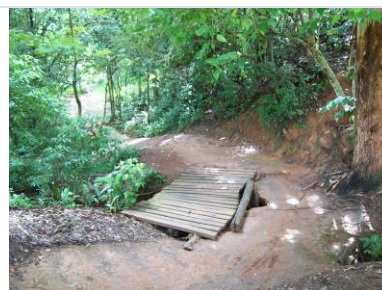
Foto 04. – Intervenção provisória na trilha. Município de Cambuí - MG
