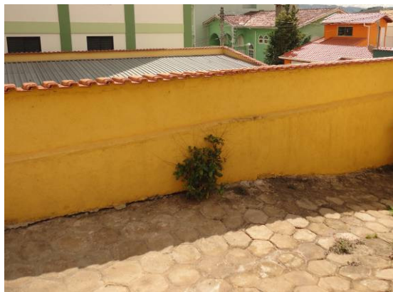
Foto 23- Muro dos fundos em perfeito estado, há apenas sujidade pontual. Município de Cambuí – MG
