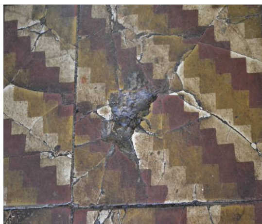
Foto 17- Ladrilho hidráulico interno em péssimo estado. Município de Cambuí – MG
