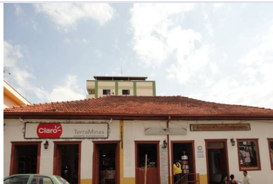
Foto 04- Foto frontal do telhado. Município de Cambuí – MG
