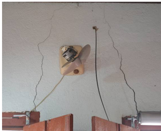
Foto 03- Trincas nas paredes da papelaria. Município de Cambuí – MG
