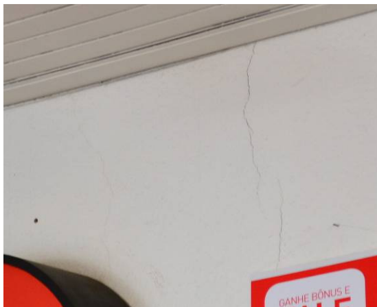
Foto 02- Trincas nas paredes da loja de celulares. Município de Cambuí – MG
