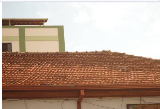
Foto 05- Detalhe do telhado em bom estado. Município de Cambuí – MG
