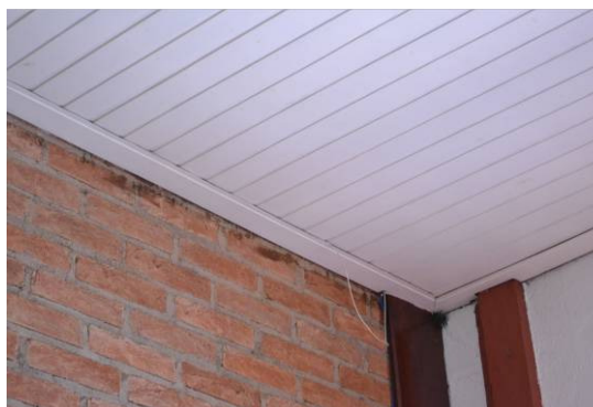
Foto 19- Forro de PVC em perfeito estado. Município de Cambuí – MG
