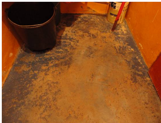
Foto 19- Cimento natado necessitando reparos. Município de Cambuí – MG
