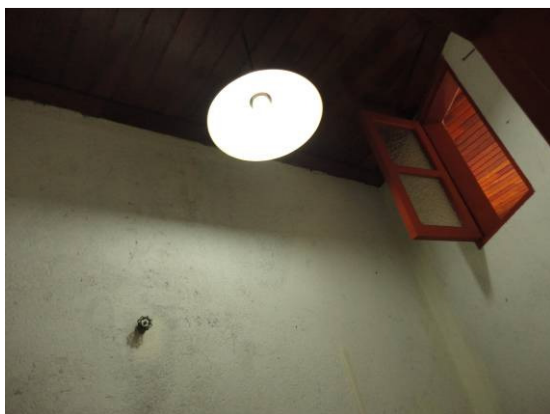
Foto 11 - Reboco com manchas de umidade. Município de Cambuí – MG
