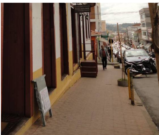
Foto 16- Calçada em bom estado. Município de Cambuí – MG
