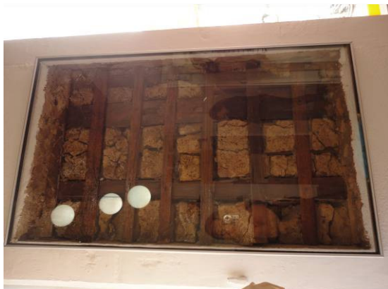
Foto 22- Janela de prospecção do pau-a-pique em perfeito estado. Município de Cambuí – MG
