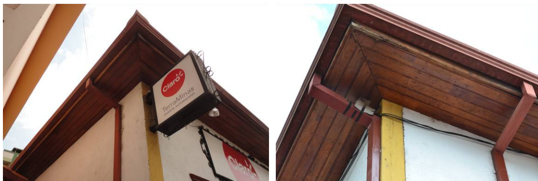
Foto 06 e Foto 07- Calhas e condutores em bom estado. O beiral em madeira possui sujidade e manchas de umidade. Município de Cambuí – MG
