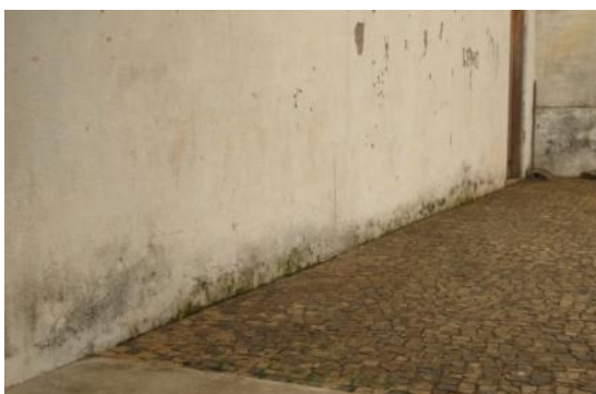
Foto 13 – Parede externa com descolamento do reboco e manchas de umidade por capilaridade e sujidade. Cambuí – MG. Catherine Horta, dez.2011.
