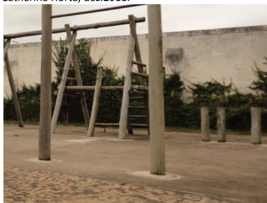
Foto 22 – Piso cimentado em bom estado. Catherine Horta, dez.2011.
