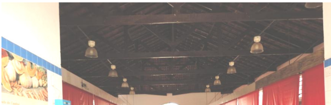
Foto 08 – Estrutura de madeira do telhado em bom estado. Cambui – MG. Catherine Horta, dez.2011.
