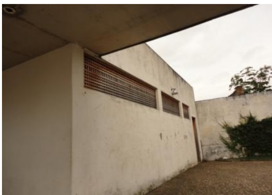
Foto 11/12 – Manchas de umidade por capilaridade e ação das intempéries no frontão da construção. Cambuí – MG. Catherine Horta, dez.2011.
