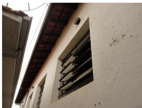
Foto 18 – Janelas em bom estado de conservação. Catherine Horta, dez.2011.
