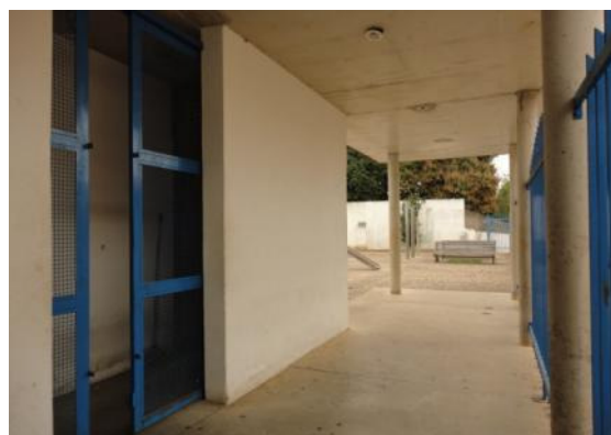
Foto 03 – Pilares de concreto em bom estado. Cambuí – MG. Catherine Horta, dez.2011.
