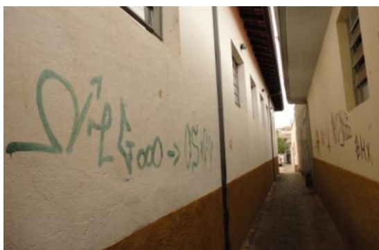
Foto 14 – Paredes pichadas com necessidade de repintura. Cambuí – MG. Catherine Horta, dez.2011.
