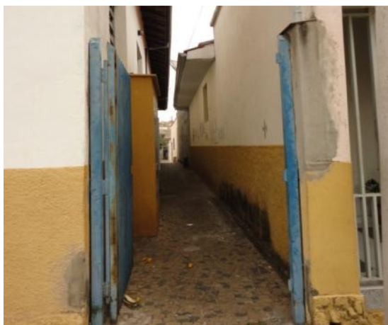
Foto 15 – Paredes com reparos no reboco mas sem repintura. Catherine Horta, dez.2011.
