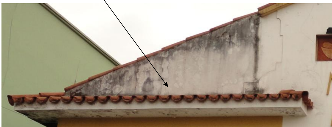
Foto 04/05/06/07 – Detalhe do frontão da edificação com manchas generalizadas de sujeira por ação das intempéries. Abaixo, detalhe platibanda com danos similares generalizados, além da perda da camada de pintura e estufamento. Cambui – MG. Catherine Horta, dez.2011.
