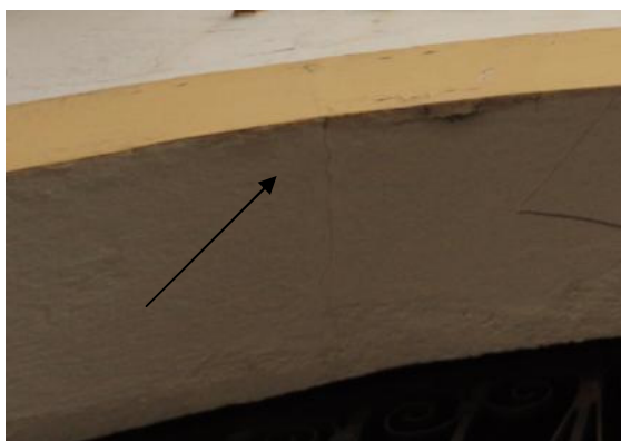
Foto 02 – Pequenas trincas na estrutura do bem. Cambuí – MG. Catherine Horta, dez.2011.
