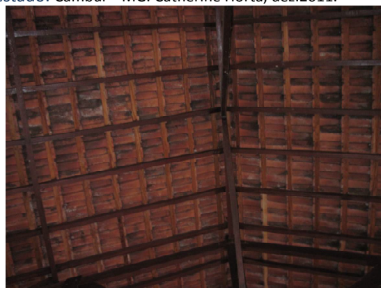
Foto 10– Telhado em telha francesa com manchas de sujidade e fungos. Cambui – MG. Catherine Horta, dez.2011.
