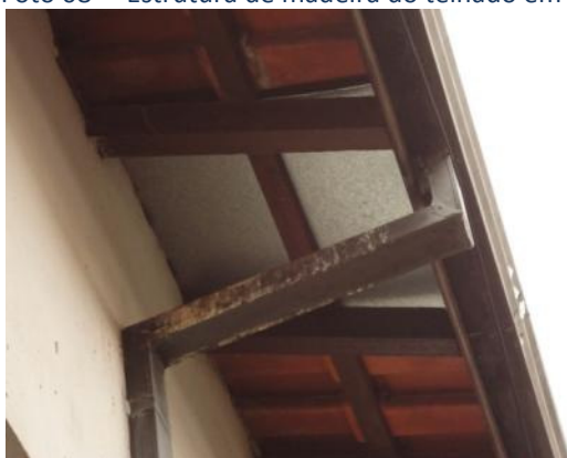
Foto 09 – Calhas com oxidação entretanto, se encontram em pleno funcionamento. Cambui – MG. Catherine Horta, dez.2011.
