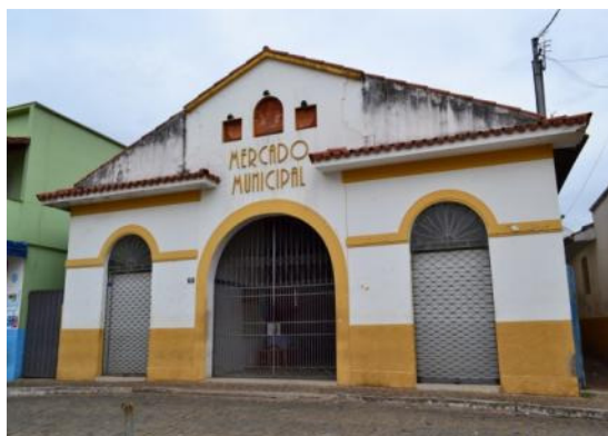
Foto 11/12 – Manchas de umidade por capilaridade e ação das intempéries no frontão da construção. Cambuí – MG. Catherine Horta, dez.2011.
