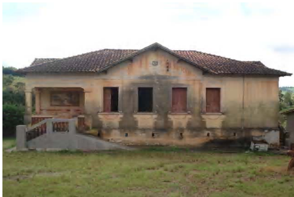
Foto 02- Fazenda São Pedro Vista geral da fachada Município de Cambuí – MG
