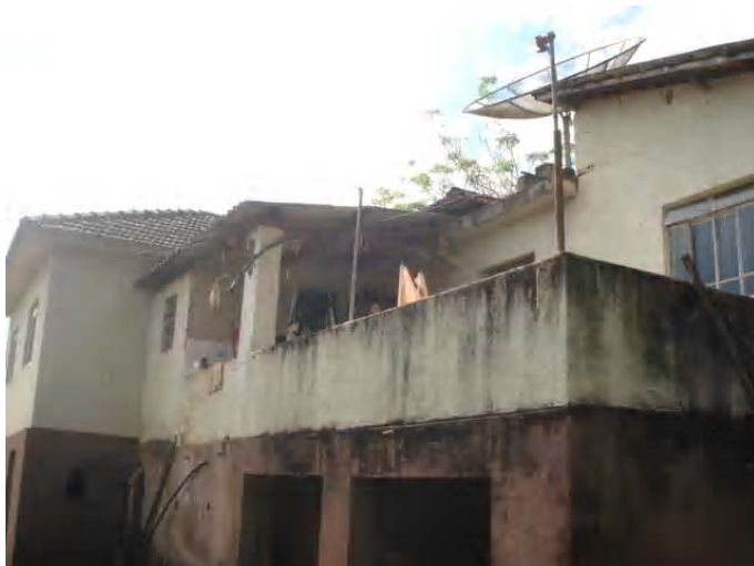
Foto 04- Casa do Sr. Miguel Silvério Pereira – Vista dos fundos da residência Município de Cambuí – MG
