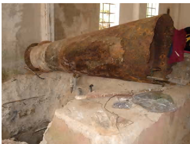
Foto 03- Casa da usina Vista interna Município de Cambuí – MG
