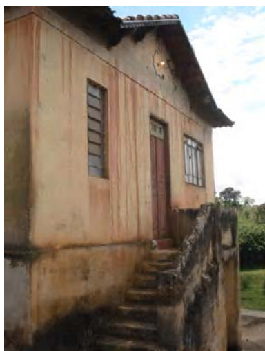
Foto 05- Fazenda São Pedro Vista da entrada lateral direita. Município de Cambuí – MG
