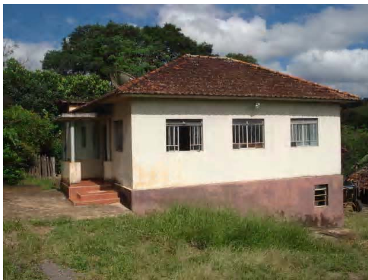
Foto 01- Vista geral da fachada Município de Cambuí – MG
