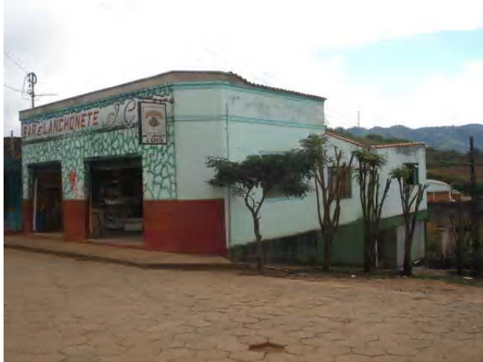
Foto 02- Vista geral. Vista lateral direita. Município de Cambuí – MG
