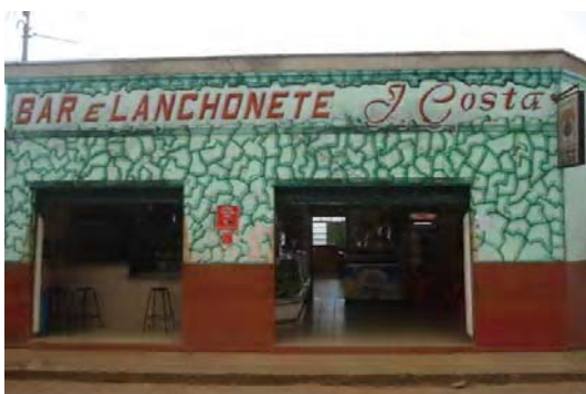
Foto 01- Vista geral da fachada Município de Cambuí – MG
