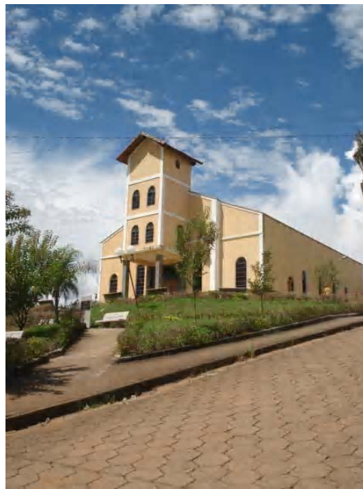
Foto 03- Foto da Igreja de Santo Antônio Povoado de Congonhal – Zona Rural Município de Cambuí – MG
