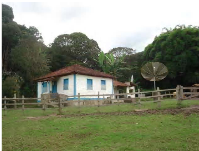
Foto 01- Vista geral da fachada Município de Cambuí – MG
