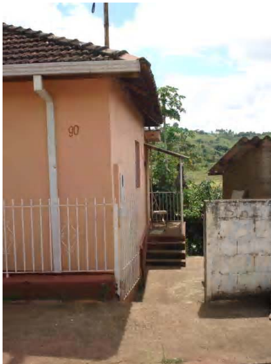
Foto 04- Casa da Sra. Ana Silvério do Nascimento Vista do portão de acesso na lateral direita. Município de Cambuí – MG
