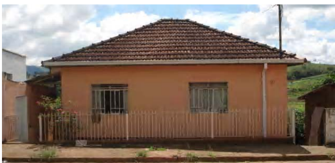
Foto 01- Vista geral da fachada Município de Cambuí – MG
