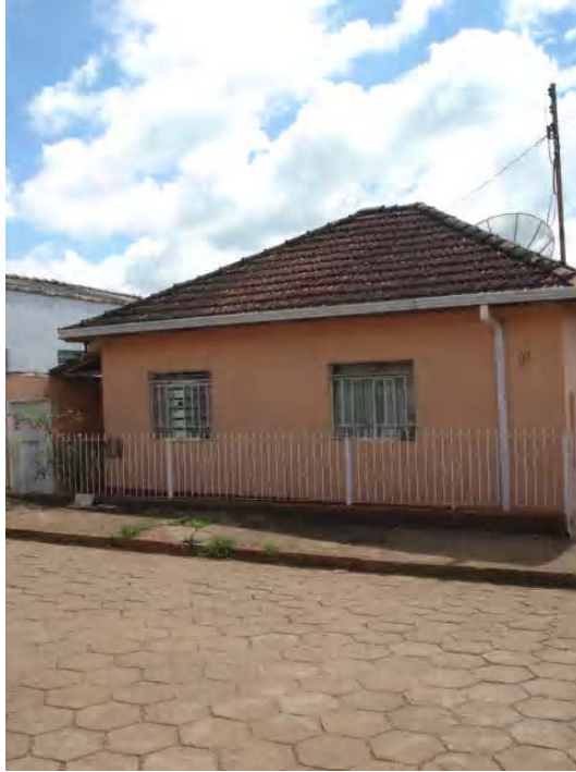
Foto 02- Vista geral da fachada Município de Cambuí – MG
