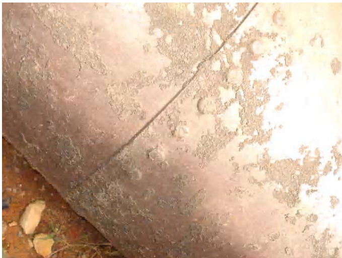
Foto 03 – Tubulação da Usina Detalhe dos rebites com emendas Município de Cambuí / MG
