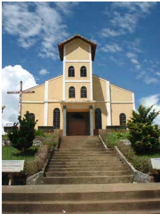
Foto 02- Foto da Igreja de Santo Antônio Povoado de Congonhal – Zona Rural Município de Cambuí – MG
