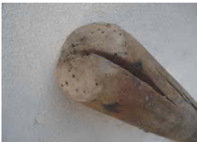
Figura 4: Socador, detalhe fissura.
