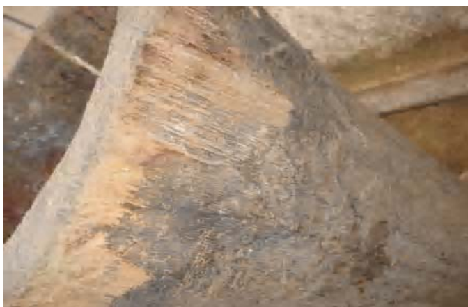
Figura 3: Lateral do pilão, detalhe de área danificada.
