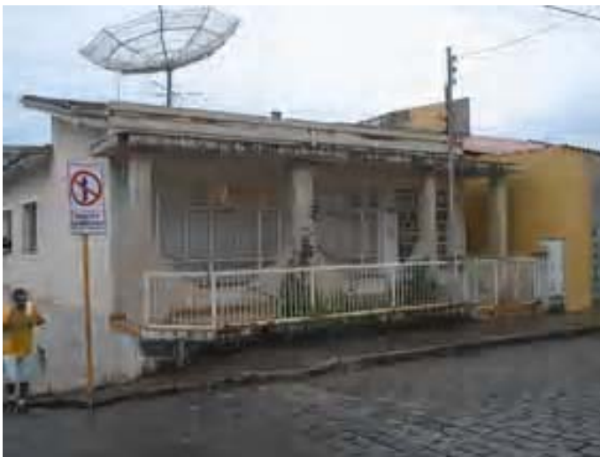
7. Bem Imóvel (BI) - Residência na Rua Padre Caramuru, 345 . Inventariado em 2006 para o exercício de 2007.
