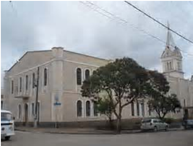
Foto 03- Isométrica fachada posterior e lateral esquerda Igreja Nossa Senhora do Carmo. Município de Cambuí, Distrito Sede. Edificação à Praça Prof. Maximiniano Lambert, 149 Data: janeiro de 2006
