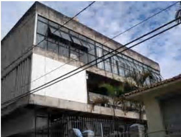
Foto 03- Isométrica fachada lateral direita e trecho fachada frontal. Município de Cambuí, Distrito Sede Edificação à Praça Coronel Justiniano, 164 - Centro. Data: janeiro de 2006
