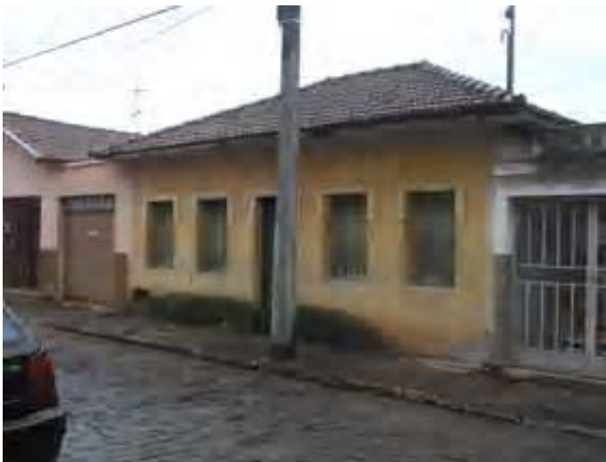
6. Bem Imóvel (BI) - Residência na Rua Padre Caramuru, 383. Inventariado em 2006 para o exercício de 2007.
