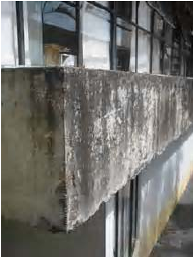
Foto 09- Manchas de sujidade e quinas danificadas na estrutura do edifício, localizado na fachada lateral direita. Município de Cambuí, Distrito Sede Edificação à Praça Coronel Justiniano, 164 - Centro Data: janeiro de 2006
