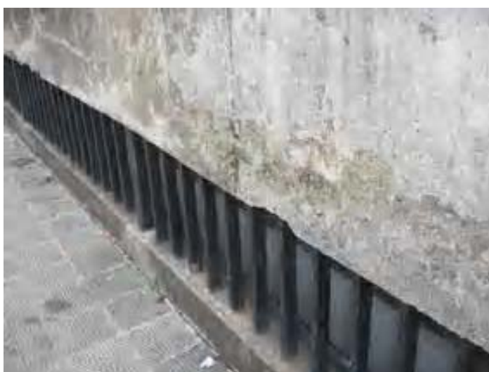
Foto 07- Detalhe quinas de concreto danificado e localizado na fachada frontal. Município de Cambuí, Distrito Sede Edificação à Praça Coronel Justiniano, 164 - Centro Data: janeiro de 2006
