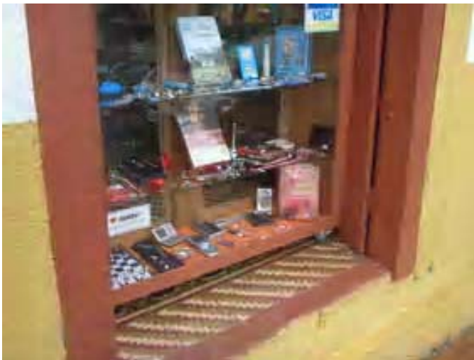
Foto 03- Detalhe porta-vitrine casarão. Atenção para piso em ladrilho hidráulico Município de Cambuí Distrito Sede Edificação à Praça Coronel Justiniano, 164 - Centro Data: janeiro de 2006
