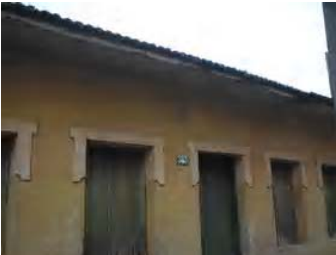
Foto 03- Detalhe vãos fachada frontal Município de Cambuí Distrito Sede Edificação à Rua Padre Caramuru, 383 Data: janeiro de 2006
