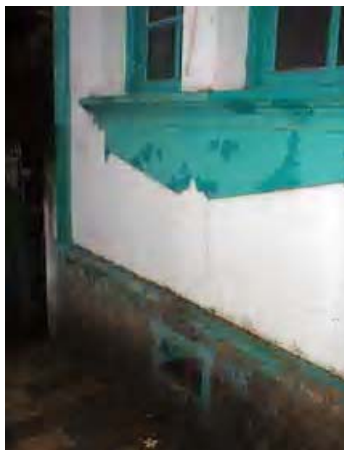
Foto 05- Detalhe massa saliente sob peitoril da janela fachada frontal Município de Cambuí Distrito Sede Edificação à Rua Governador Valadares, 237 Data: janeiro de 2006
