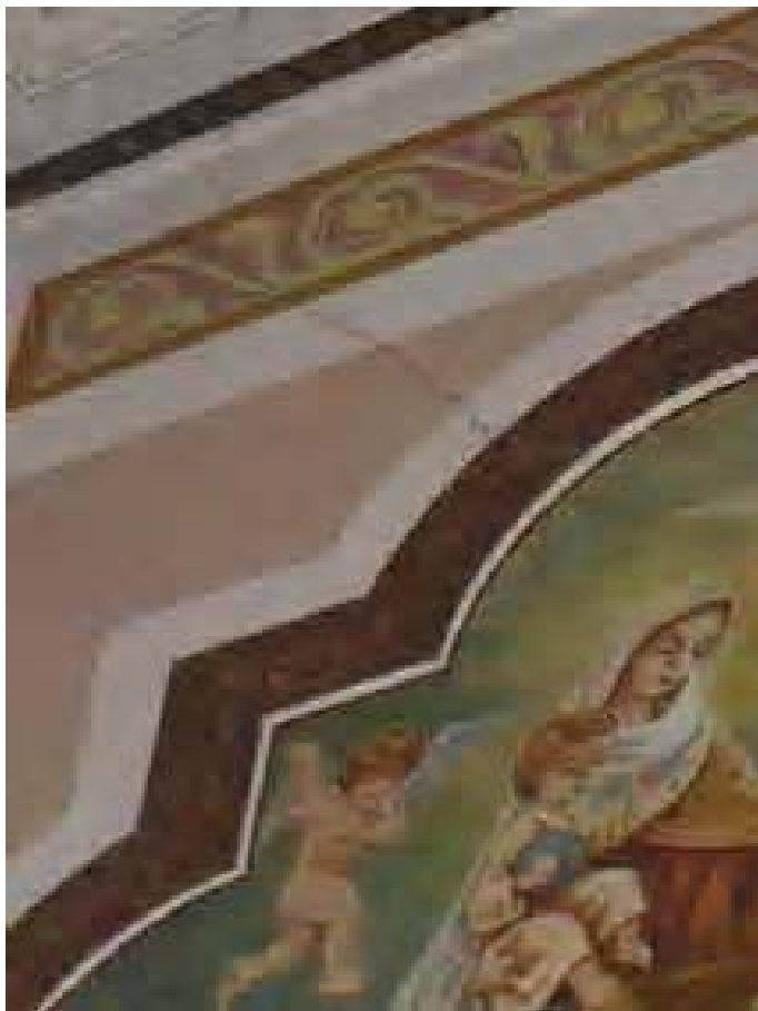
Foto 11- Trincas pintura parede. Município de Cambuí Distrito Sede Edificação à Praça Prof. Maximiniano Lambert, 149 Data: janeiro de 2006
