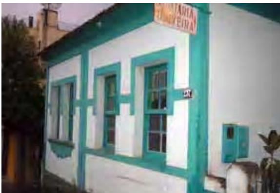
Foto 03- Isométrica fachada frontal e lateral direita. Município de Cambuí, Distrito Sede Edificação à Rua Governador Valadares, 237 Data: janeiro de 2006
