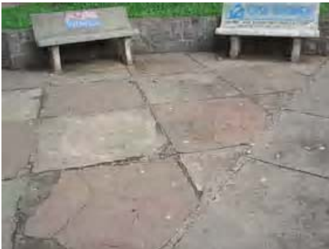
Foto 09- Piso em cimento, liso e xadrez, necessitando de urgente restauro. Município de Cambuí, Distrito Sede Praça da Matriz de Cambuí. Data: janeiro de 2006
