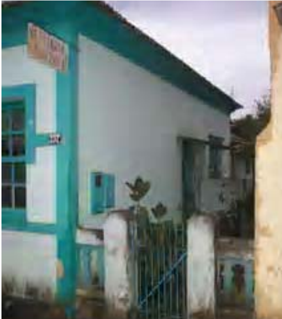
Foto 02- Fachada lateral direita. Município de Cambuí, Distrito Sede. Edificação à Rua Governador Valadares, 237. Data: janeiro de 2006
