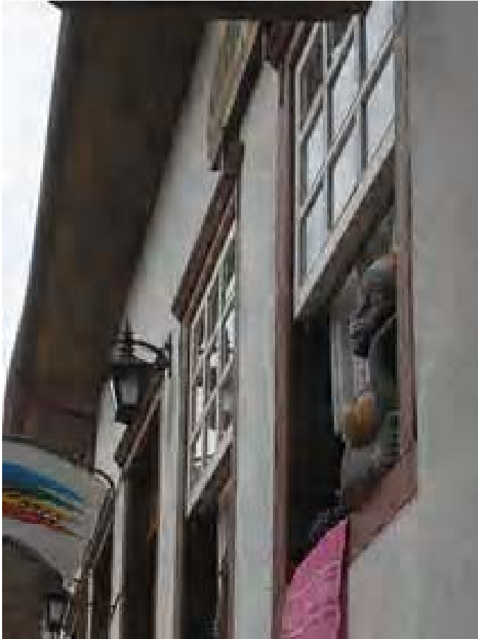
Foto 02- Detalhes vãos e beiral da fachada frontal. Município de Cambuí, Distrito Sede. Edificação à Praça Coronel Justiniano, 164 - Centro Data: janeiro de 2006
