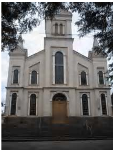
Foto 01- Fachada frontal Igreja Nossa Senhora do Carmo Município de Cambuí
