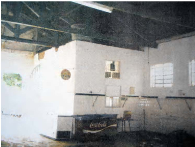
Foto 03- Interior do mercado mostrando estado de deterioração na década de 90, acervo Brasil Arquitetura. Município de Cambuí, Distrito Sede Edificação à Praça Coronel Maximiano, 36 - Centro Data: década de 90
