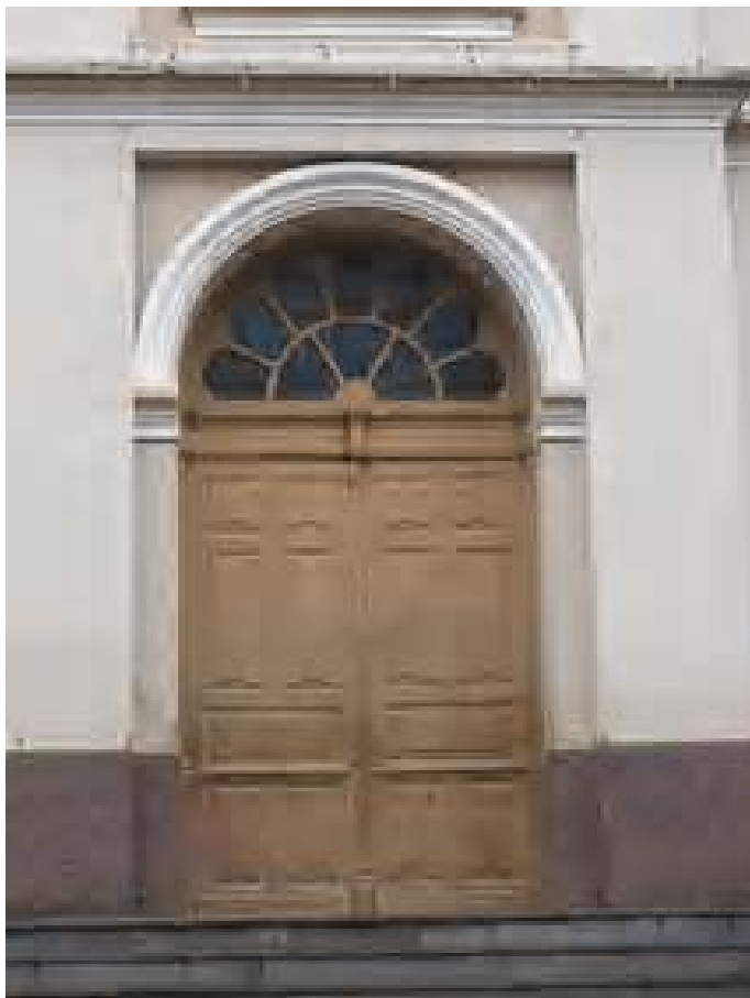
Foto 07- Porta central fachada frontal.
