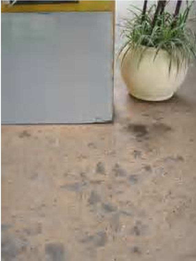
Foto 08- Piso térreo- atenção para manchas de sujidades e umidade. Município de Cambuí, Distrito Sede Edificação à Praça Coronel Justiniano, 164 - Centro Data: janeiro de 2006
