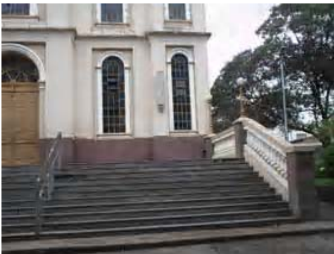
Foto 04- Detalhe escadaria fachada frontal Igreja Nossa Senhora do Carmo. Município de Cambuí, Distrito Sede Edificação à Praça Prof. Maximiniano Lambert, 149 Data: janeiro de 2006
