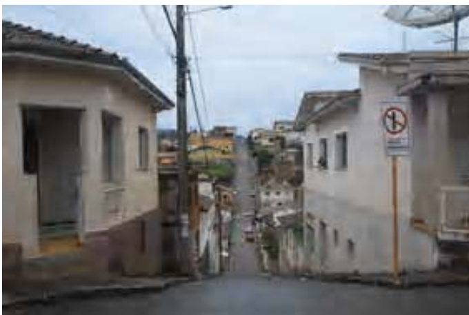
Foto 04- Isométrica fachada lateral esquerda. Município de Cambuí, Distrito Sede. Edificação à Rua Padre Caramuru, 345. Data: janeiro de 2006
