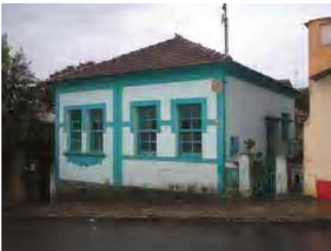
8. Bem Imóvel (BI) - Residência na Rua Governador Valadares, 237. Inventariado em 2006 para o exercício de 2007.
