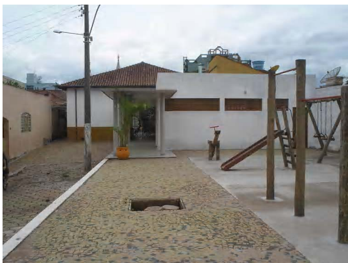
Foto 06- Vista fachada posterior Mercado Municipal, anexo e área de lazer. Município de Cambuí, Distrito Sede Edificação à Praça Coronel Maximiano, 36 - Centro Data: fevereiro de 2006
