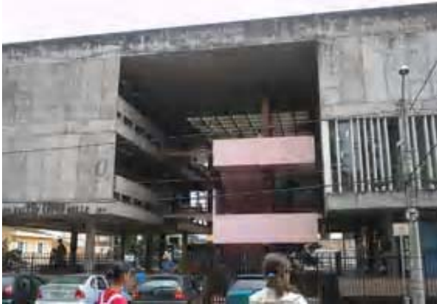
Foto 02- Detalhe fachada frontal. Município de Cambuí, Distrito Sede. Edificação à Praça Coronel Justiniano, 164 - Centro. Data: janeiro de 2006
