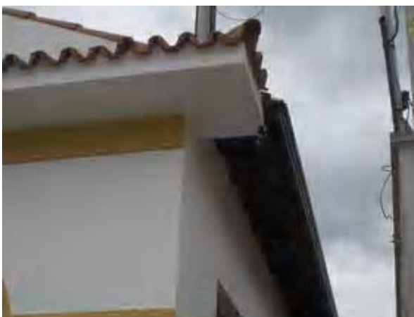
Foto 12- Detalhe telha sobre laje e beiral referente à fachada lateral direita. Município de Cambuí, Distrito Sede. Edificação à Praça Coronel Maximiano, 36 - Centro. Data: Janeiro de 2006
