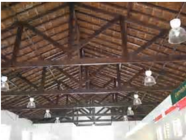
Foto 13- Estrutura telhado Município de Cambuí, Distrito Sede Edificação à Praça Coronel Maximiano, 36 - Centro Data: fevereiro de 2006
