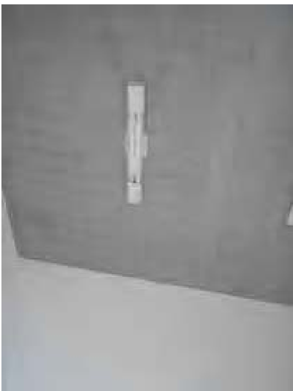
Foto 15- Laje lojas com acesso independente - fachada frontal Município de Cambuí, Distrito Sede Edificação à Praça Coronel Maximiano, 36 - Centro Data: fevereiro de 2006
