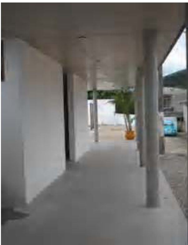
Foto 20- Laje acesso banheiros e área de lazer. Município de Cambuí, Distrito Sede. Edificação à Praça Coronel Maximiano, 36 - Centro. Data: Janeiro de 2006
