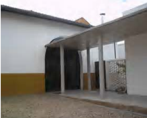
Foto 19- Vista externa laje, anexo e fachada posterior Mercado. Município de Cambuí, Distrito Sede. Edificação à Praça Coronel Maximiano, 36 - Centro Data: Janeiro de 2006
