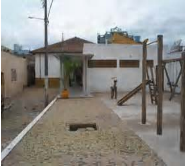
Foto 22- Vista posterior Mercado, anexo e área de lazer. Município de Cambuí, Distrito Sede. Edificação à Praça Coronel Maximiano, 36 - Centro. Data: Janeiro de 2006
