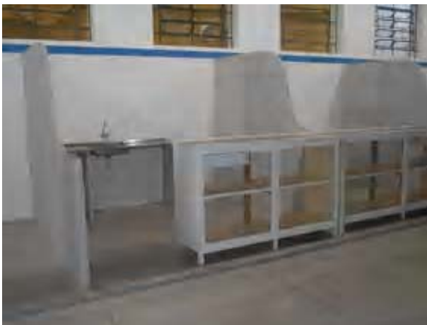
Foto 07- Alvenaria e revestimento interno boxes. Município de Cambuí, Distrito Sede. Edificação à Praça Coronel Maximiano, 36 - Centro Data: Janeiro de 2006
