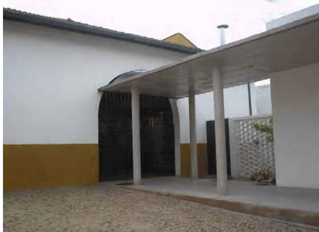
Foto 05- Acesso Mercado Municipal ao anexo (sanitários e área de lazer). Município de Cambuí, Distrito Sede. Edificação à Praça Coronel Maximiano, 36 - Centro Data: fevereiro de 2006
