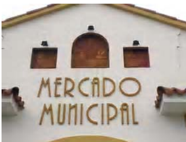
Foto 02- Detalhes nichos fachada frontal. Município de Cambuí, Distrito Sede. Edificação à Praça Coronel Maximiano, 36 - Centro Data: Janeiro de 2006
