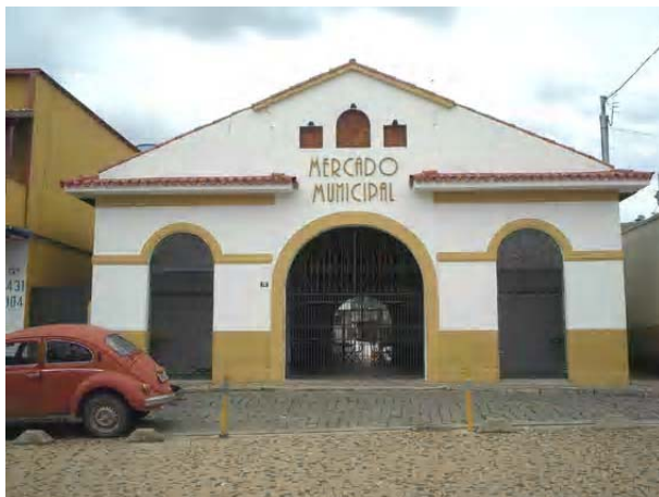
Foto 01- Vista fachada frontal. Município de Cambuí, Distrito Sede. Edificação à Praça Coronel Maximiano, 36 - Centro Data: Janeiro de 2006
