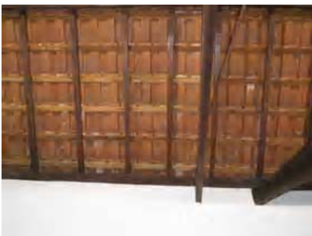
Foto 14- Detalhe interno telhas Município de Cambuí, Distrito Sede Edificação à Praça Coronel Maximiano, 36 - Centro Data: fevereiro de 2006
