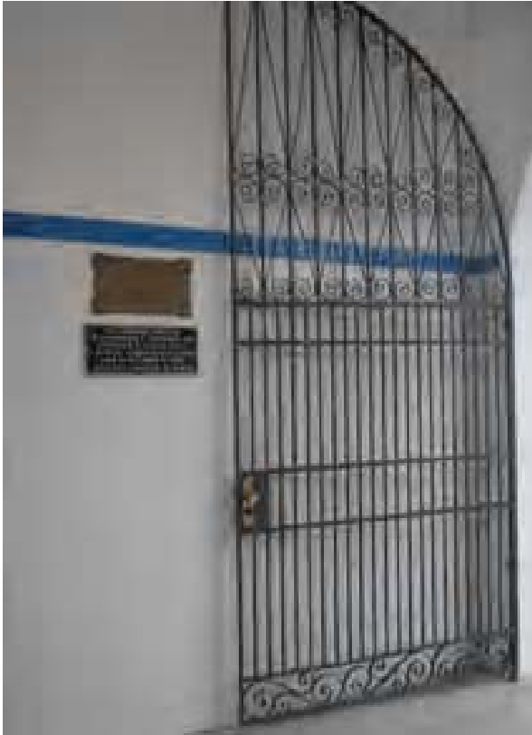
Foto 10- Portão fachada frontal. Município de Cambuí, Distrito Sede. Edificação à Praça Coronel Maximiano, 36 - Centro Data: Janeiro de 2006
