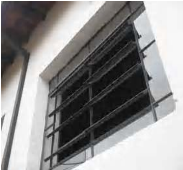
Foto 17- Detalhe beiral, condutor e basculante na fachada lateral esquerda. Município de Cambuí, Distrito Sede Edificação à Praça Coronel Maximiano, 36 - Centro. Data: Janeiro de 2006
