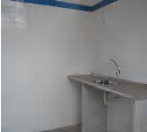
Foto 16- Alvenaria e acabamento interno lojas com acesso independente na fachada frontal. Município de Cambuí, Distrito Sede. Edificação à Praça Coronel Maximiano, 36 - Centro. Data: Janeiro de 2006
