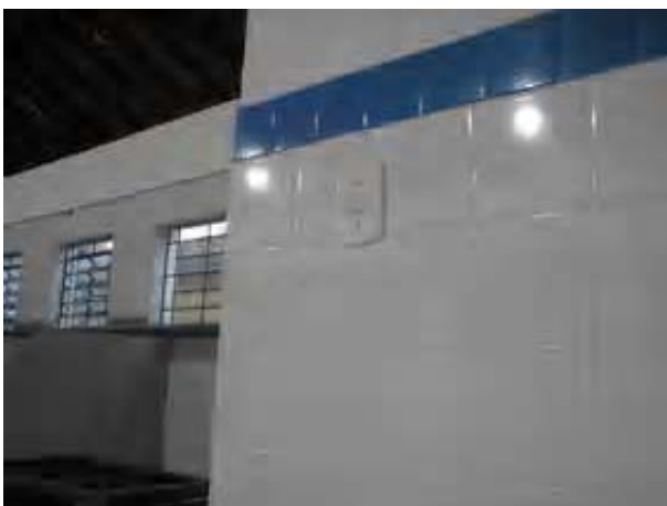
Foto 09- Detalhe revestimento cerâmico. Município de Cambuí, Distrito Sede. Edificação à Praça Coronel Maximiano, 36 - Centro Data: Janeiro de 2006
