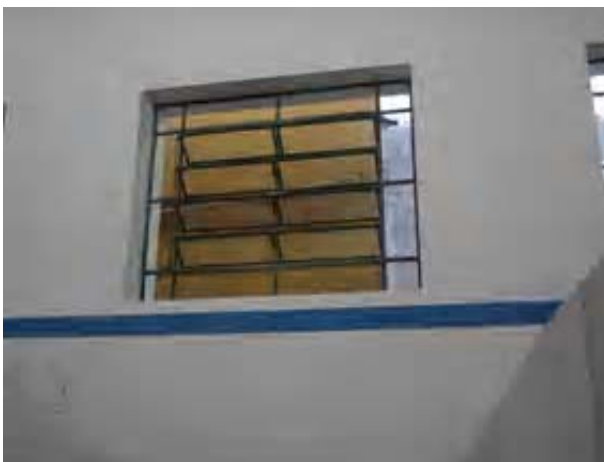
Foto 08- Detalhe basculante fachada lateral direita. Município de Cambuí, Distrito Sede. Edificação à Praça Coronel Maximiano, 36 - Centro. Data: Janeiro de 2006
