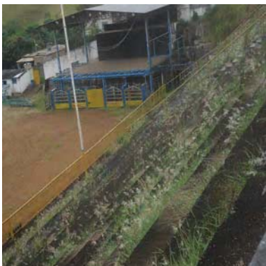
FOTO 40: Detalhe da arribancada escavada na encosta com acabamento cimentado - desativada.
