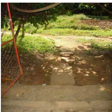
FOTO 14: Pavimentação da entrada da mata. MUNICÍPIO: Cambuí DATA: 14/03/08
