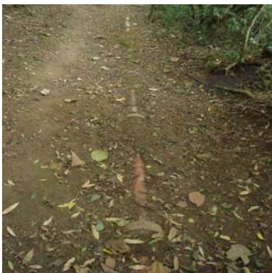
FOTO 35: Drenagem pluvial superficial. Canos visíveis.
