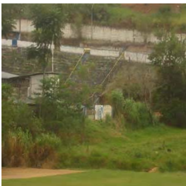
FOTO 36: Ao fundo - Arquibancada escavada na encosta com acabamento cimentado - desativada.
