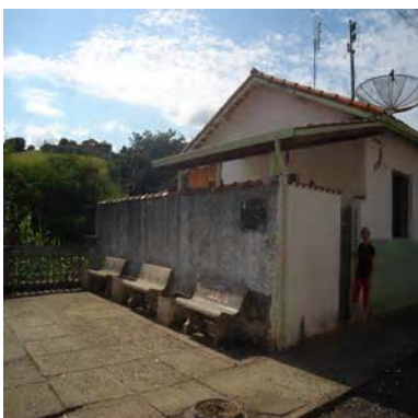
FOTO 02: Vista lateral direita da pracinha anexa à mata
