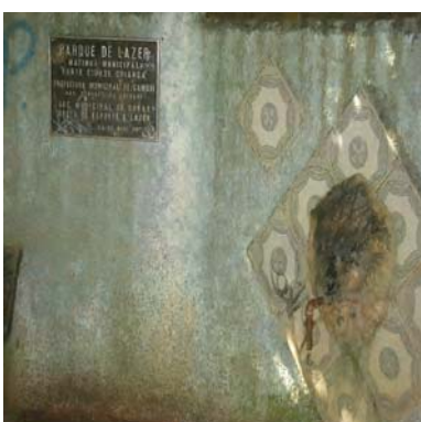
FOTO 12: detalhe da fonte atualmente seca e da placa de identificação MUNICÍPIO: Cambuí DATA: 14/03/08
