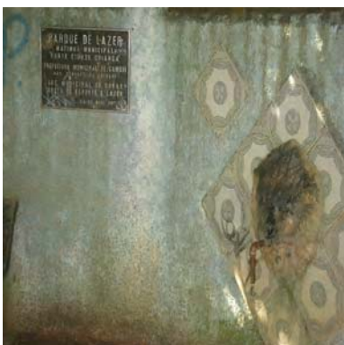
FOTO 12: detalhe da fonte atualmente seca e da placa de identificação MUNICÍPIO: Cambuí DATA: 14/03/07
