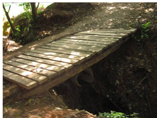
Foto 08- Tubo condutor de água entupido. Cambuí - MG
