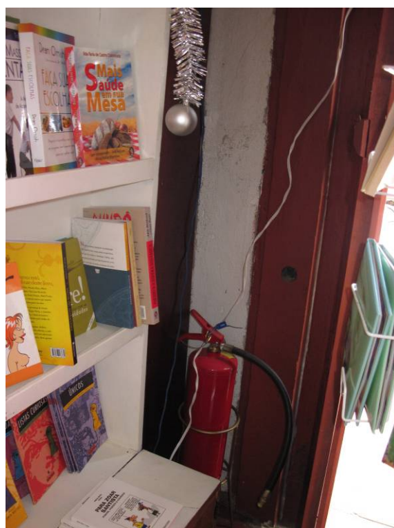
Foto 44 – Extintor de incêndio mal localizado e presença de fiação elétrica irregular. Imóvel Rua João Moreira Sales, 37 Data: Dezembro de 2010
