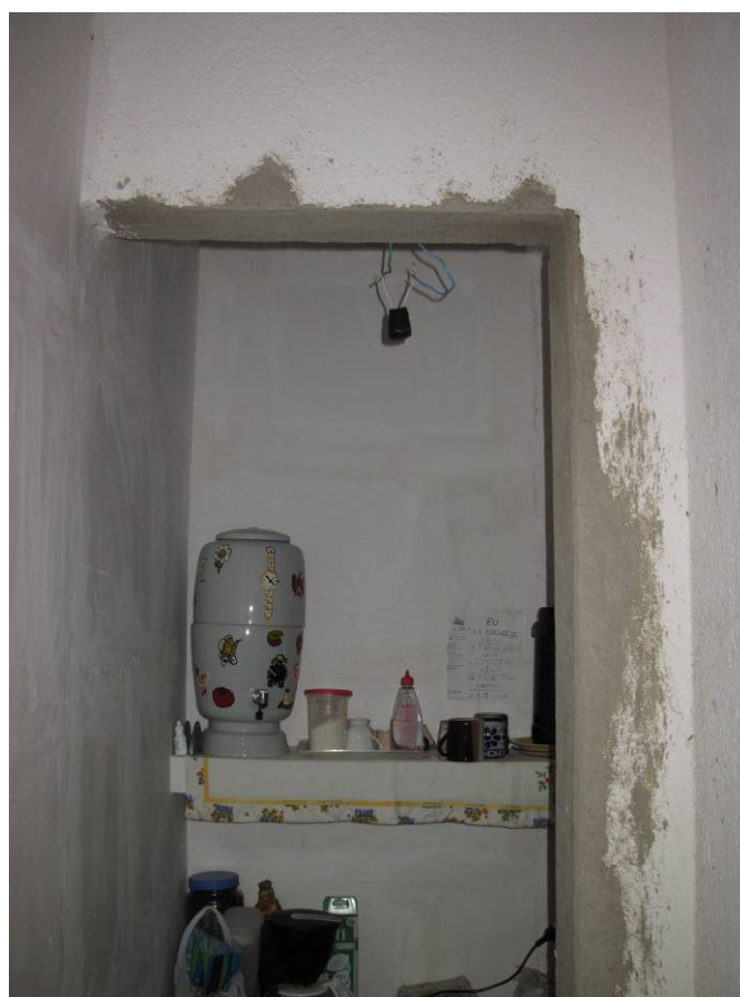
Foto 08 – Parede com reboco a vista e vão sem vedação e marco. Instalação elétrica com fiação exposta. Imóvel Rua João Moreira Sales, 37 Data: Dezembro de 2010
