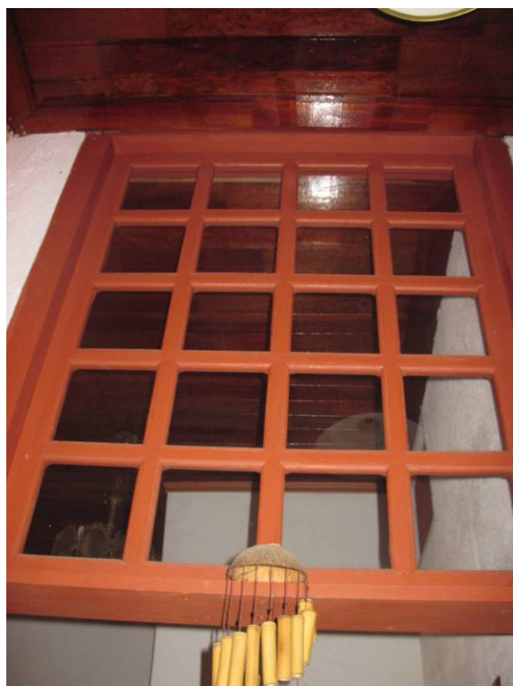
Foto 18 – Bandeira fixa, bom estado de conservação. Imóvel Rua João Moreira Sales, 37 Data: Dezembro de 2010
