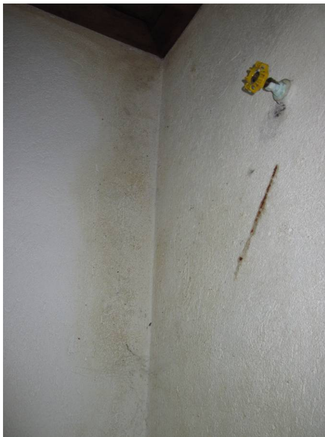
Foto 07 – Parede com sujidades causadas por águas pluviais. Imóvel Rua João Moreira Sales, 37 Data: Dezembro de 2010
