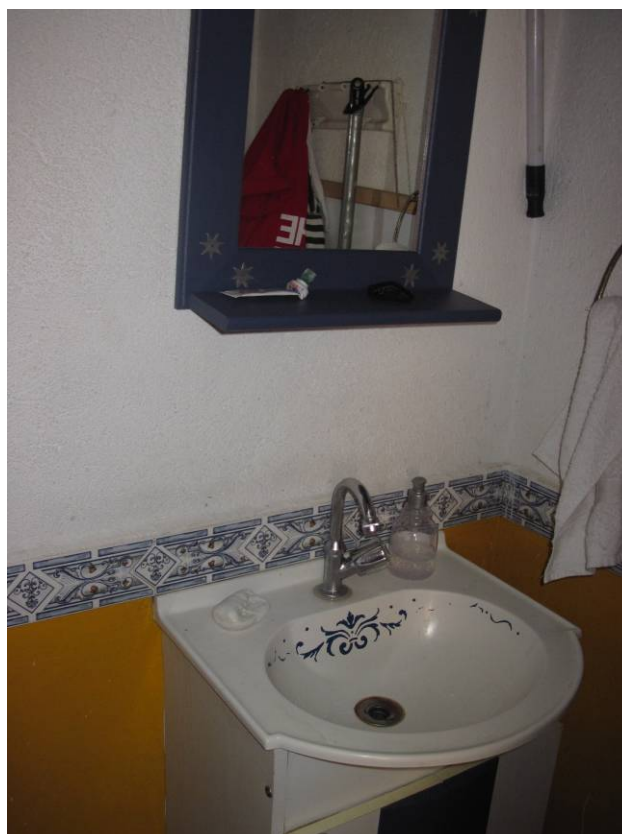
Foto 12 – Lavabo Livraria – bom estado de conservação. Imóvel Rua João Moreira Sales, 37 Data: Dezembro de 2010
