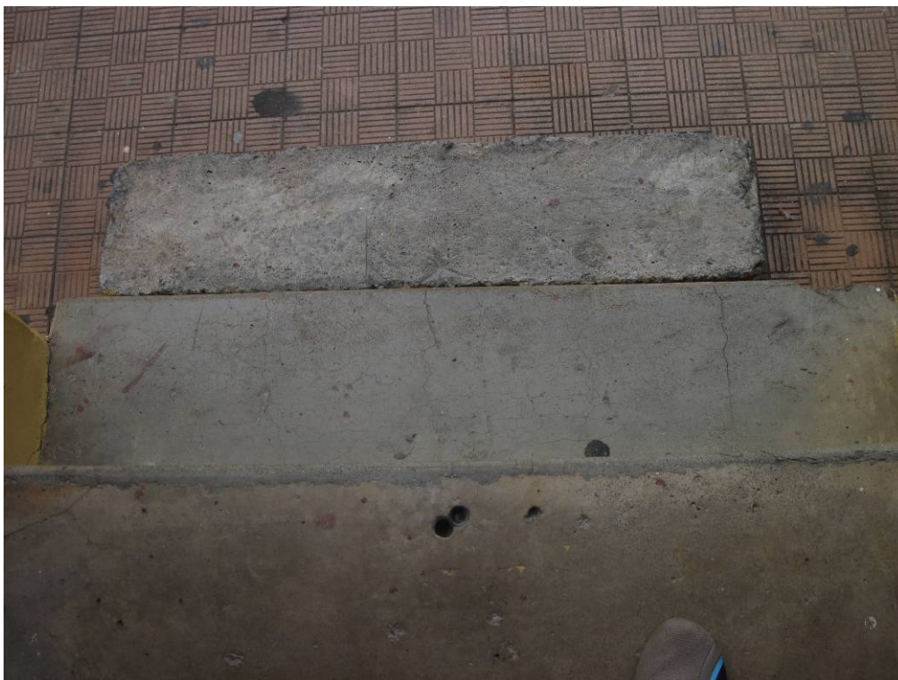
Foto 27 – Piso externo – passeio – muitas sujidades. Imóvel Rua João Moreira Sales, 37 Data: Dezembro de 2010
