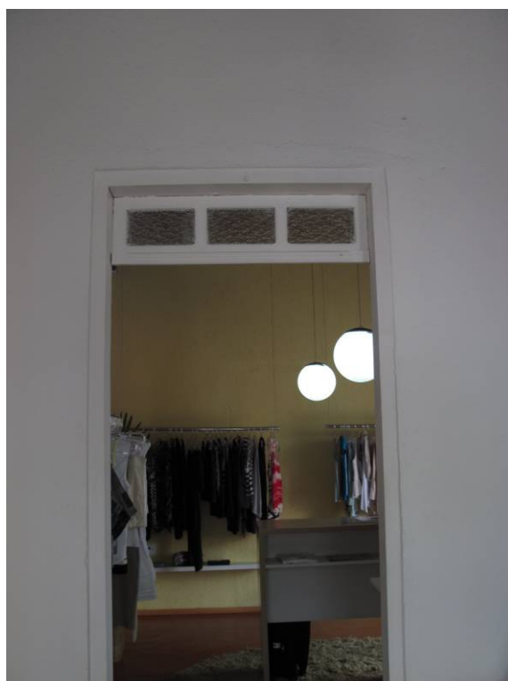
Foto 19 – Bandeira fixa – bom estado de conservação. Imóvel Rua João Moreira Sales, 37 Data: Dezembro de 2010
