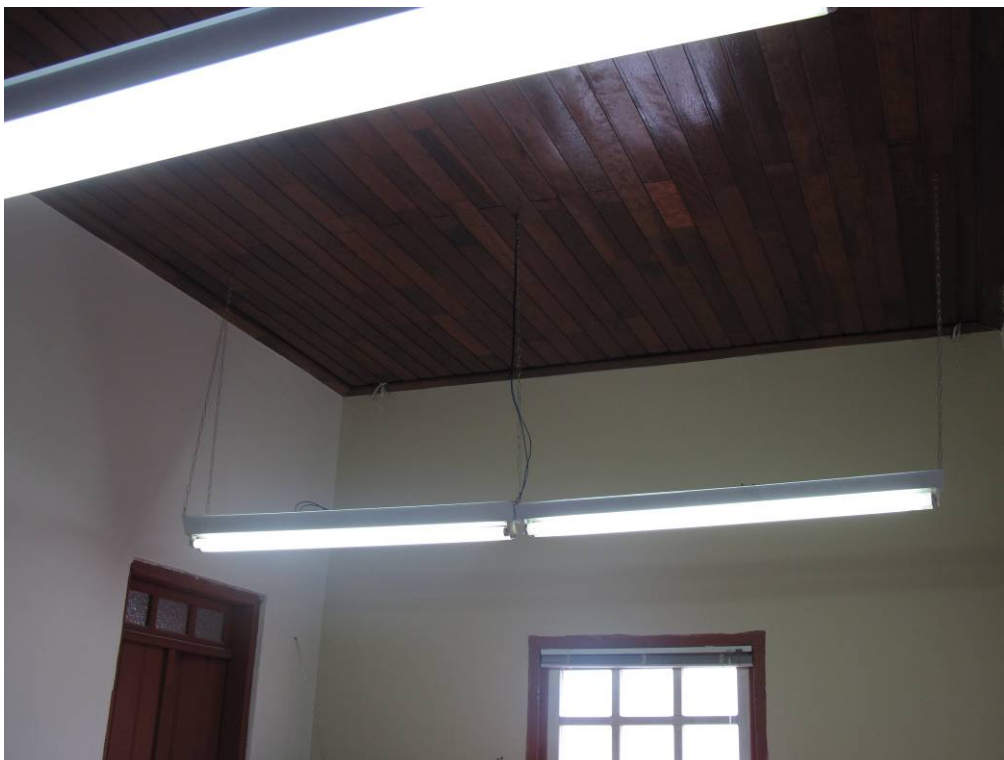
Foto 31 – Mais uma vista do forro e instalação elétrica, bom estado de conservação. Imóvel Rua João Moreira Sales, 37 Data: Dezembro de 2010
