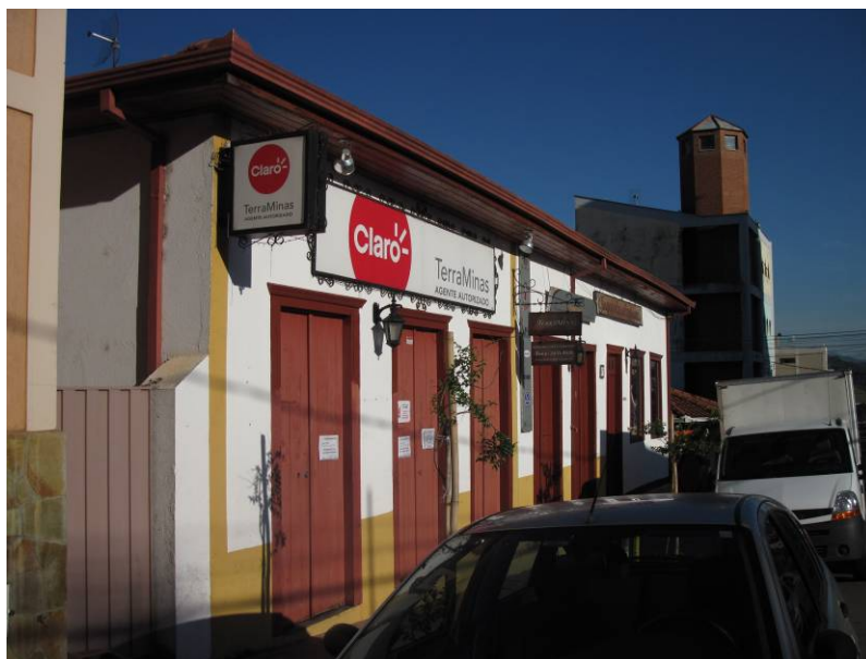
Foto 01 – Fachada frontal. Imóvel Rua João Moreira Sales, 37 Data: Dezembro de 2010
