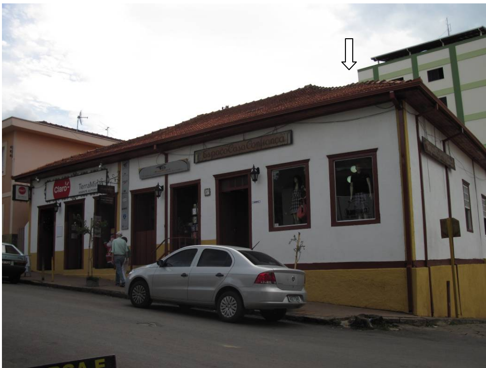
Foto 05 – Estrutura do telhado com abalo na porção direita. Imóvel Rua João Moreira Sales, 37 Data: Dezembro de 2010
