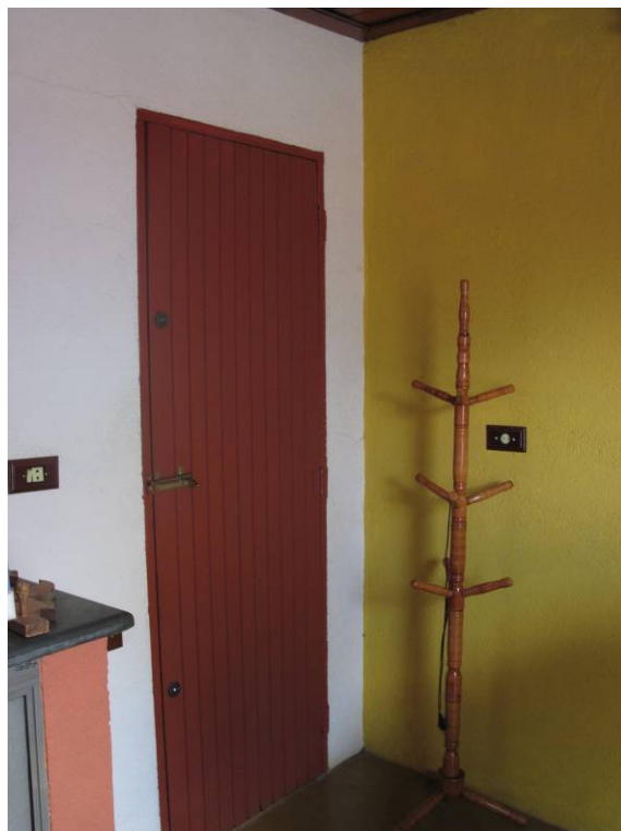
Foto 15 – Porta de madeira – bom estado de conservação. Imóvel Rua João Moreira Sales, 37 Data: Dezembro de 2010
