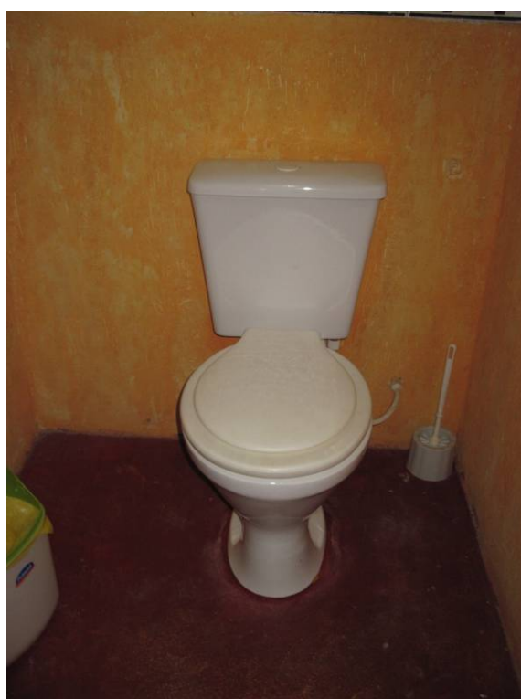
Foto 26 – Piso cimento natado banheiro – bom estado de conservação. Imóvel Rua João Moreira Sales, 37 Data: Dezembro de 2010
