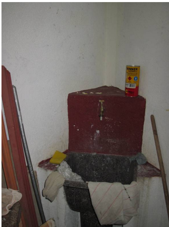
Foto 39 – Instalação hidráulica malconservada. Imóvel Rua João Moreira Sales, 37 Data: Dezembro de 2010
