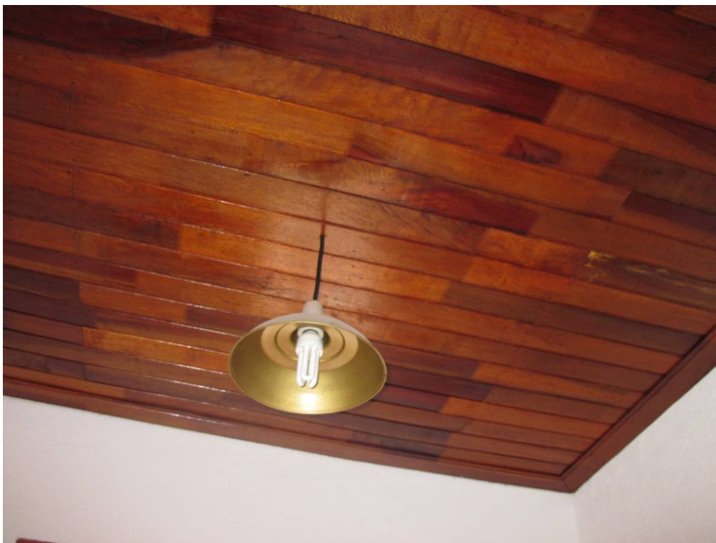
Foto 29 – Forro de madeira e instalação elétrica – bom estado de conservação. Imóvel Rua João Moreira Sales, 37 Data: Dezembro de 2010
