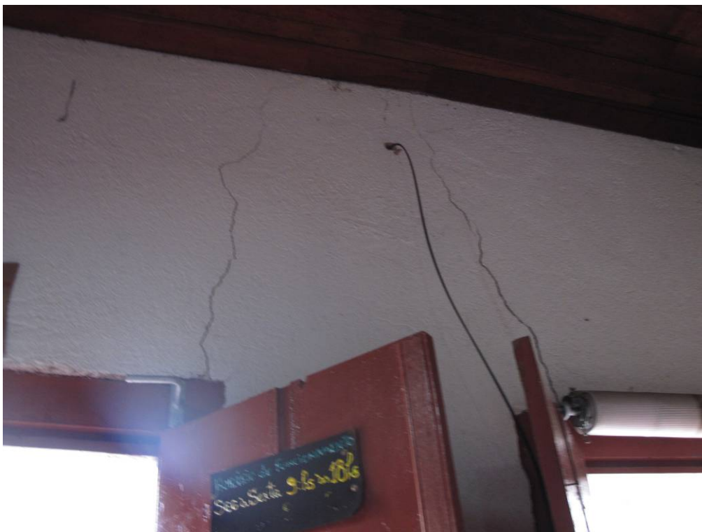
Foto 04 – Detalhe das trincas sobre as portas na parede da Livraria. Imóvel Rua João Moreira Sales, 37 Data: Dezembro de 2010
