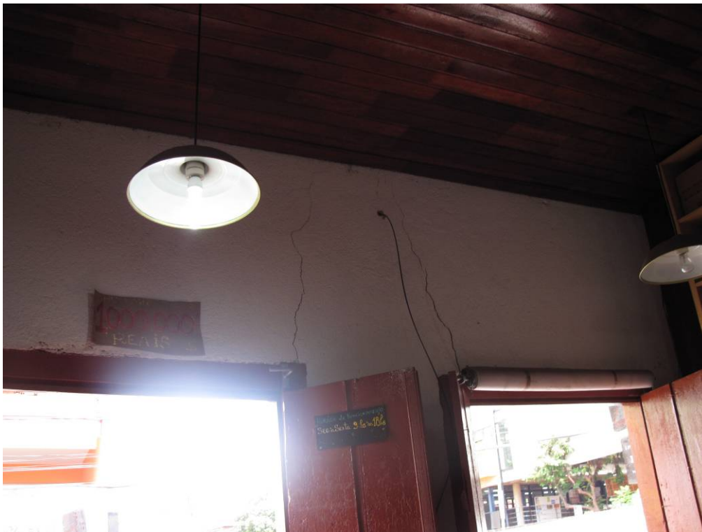
Foto 03 – Trincas sobre as portas na parede da Livraria. Imóvel Rua João Moreira Sales, 37 Data: Dezembro de 2010
