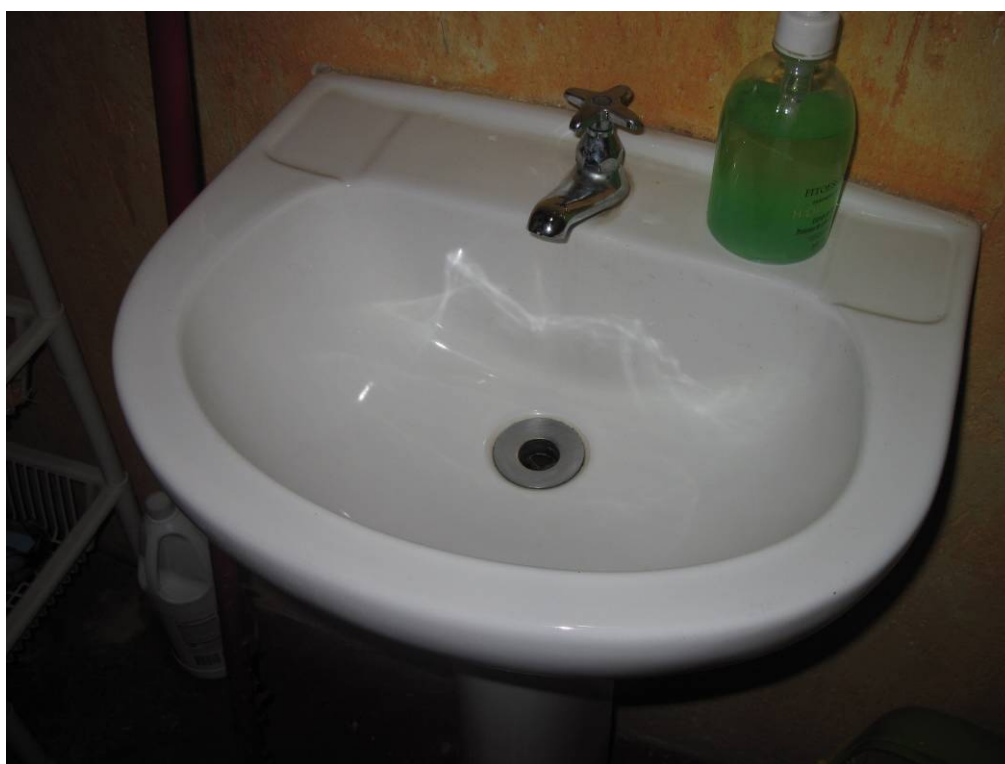
Foto 40 – Instalação hidráulica em bom estado de conservação. Imóvel Rua João Moreira Sales, 37 Data: Dezembro de 2010
