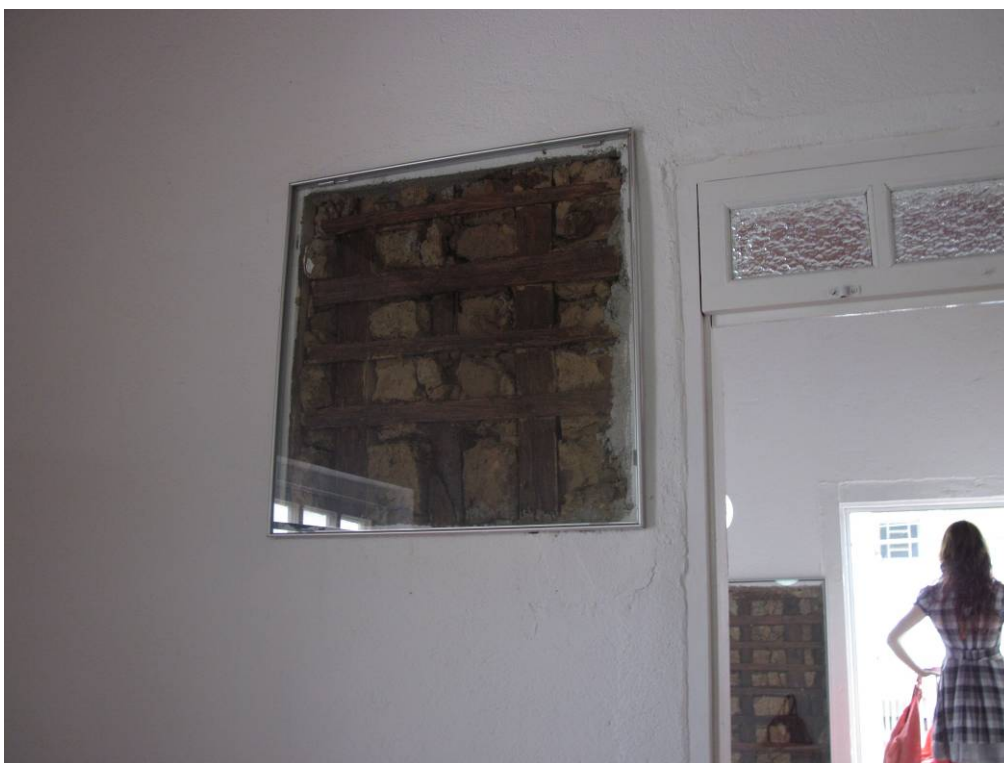
Foto 32 – Janela de prospecção – bem conservada. Em segundo plano outra janela de prospecção. Imóvel Rua João Moreira Sales, 37 Data: Dezembro de 2010
