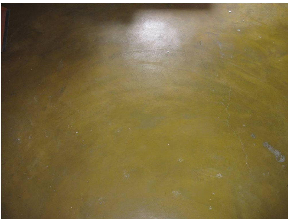
Foto 22 – Piso de cimento natado da cozinha, desgasto no revestimento e no material. Imóvel Rua João Moreira Sales, 37 Data: Dezembro de 2010
