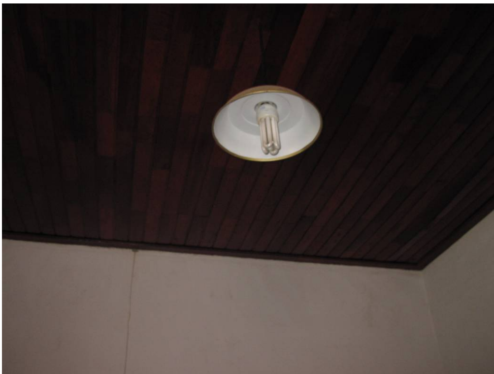
Foto 37 – Instalação elétrica regular. Imóvel Rua João Moreira Sales, 37 Data: Dezembro de 2010
