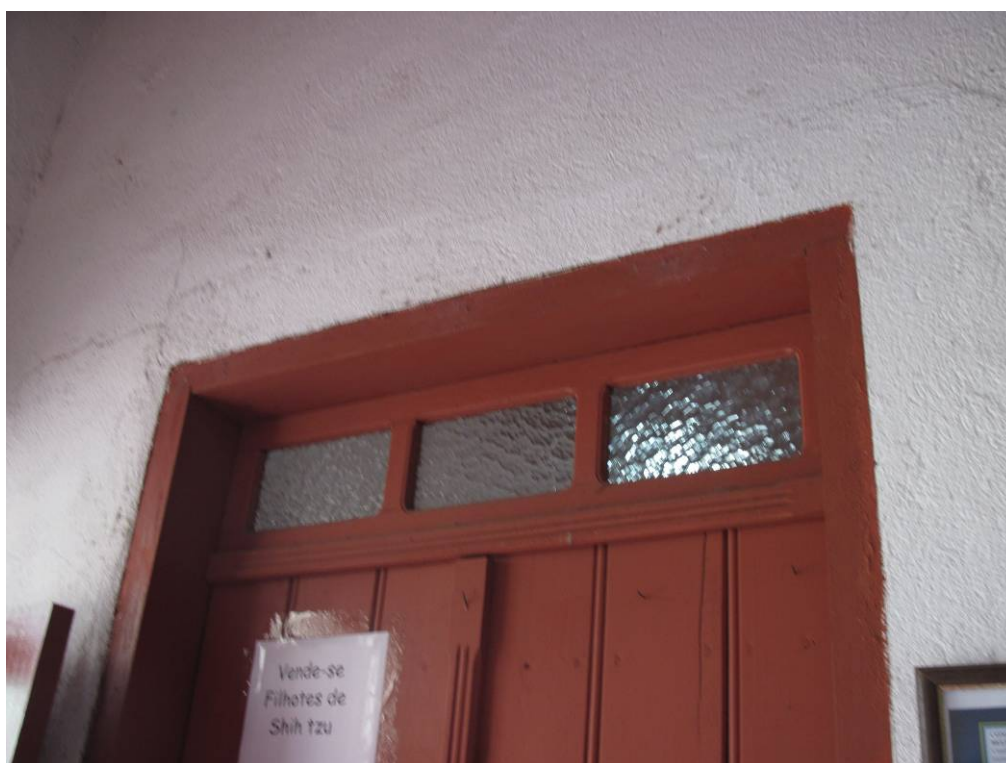
Foto 20 – Aviso fixado em porta de madeira. Imóvel Rua João Moreira Sales, 37 Data: Dezembro de 2010
