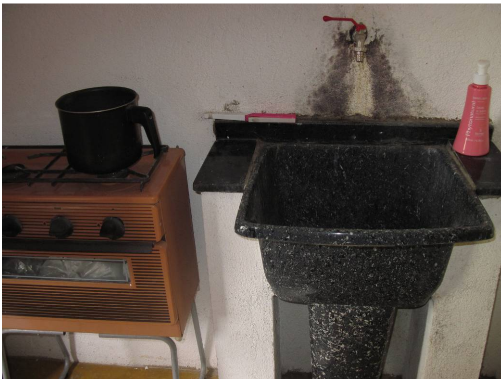
Foto 35 – Parede com mancha de infiltração causada por problema na tubulação de água. Imóvel Rua João Moreira Sales, 37 Data: Dezembro de 2010
