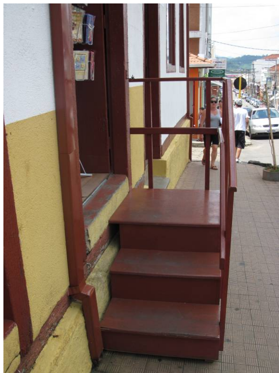
Foto 33 – Escada com desgaste no piso. Imóvel Rua João Moreira Sales, 37 Data: Dezembro de 2010
