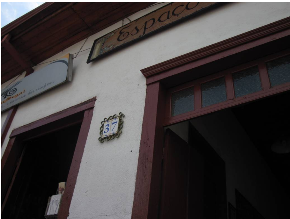
Foto 21 – Marcos, bandeira fixa com vedação de vidro e numeração do imóvel, fachada frontal – bom estado de conservação. Imóvel Rua João Moreira Sales, 37 Data: Dezembro de 2010
