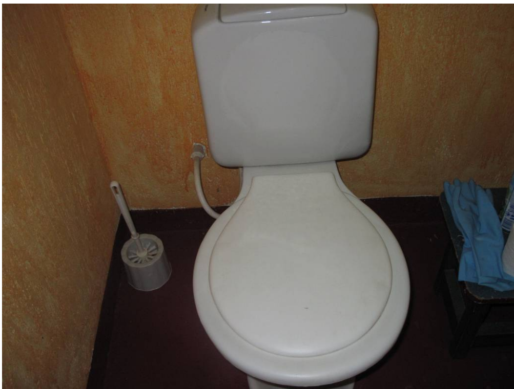
Foto 11 – Parede de estuque e vaso sanitário – bom estado de conservação. Imóvel Rua João Moreira Sales, 37 Data: Dezembro de 2010
