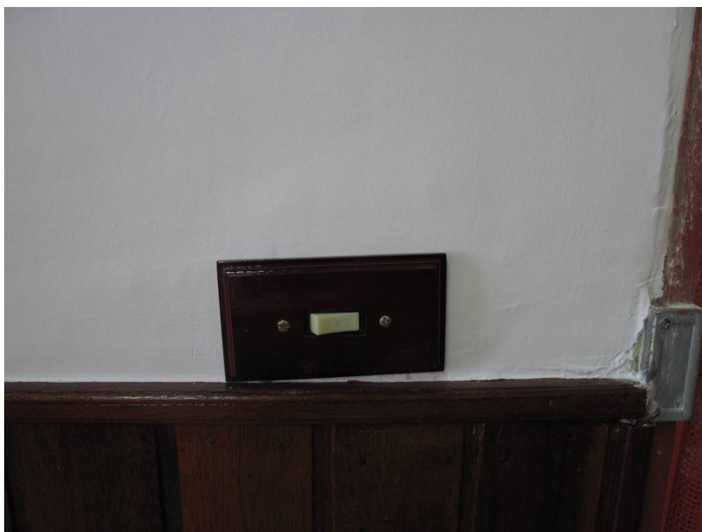
Foto 36 – Interruptor – bem conservado. Imóvel Rua João Moreira Sales, 37 Data: Dezembro de 2010
