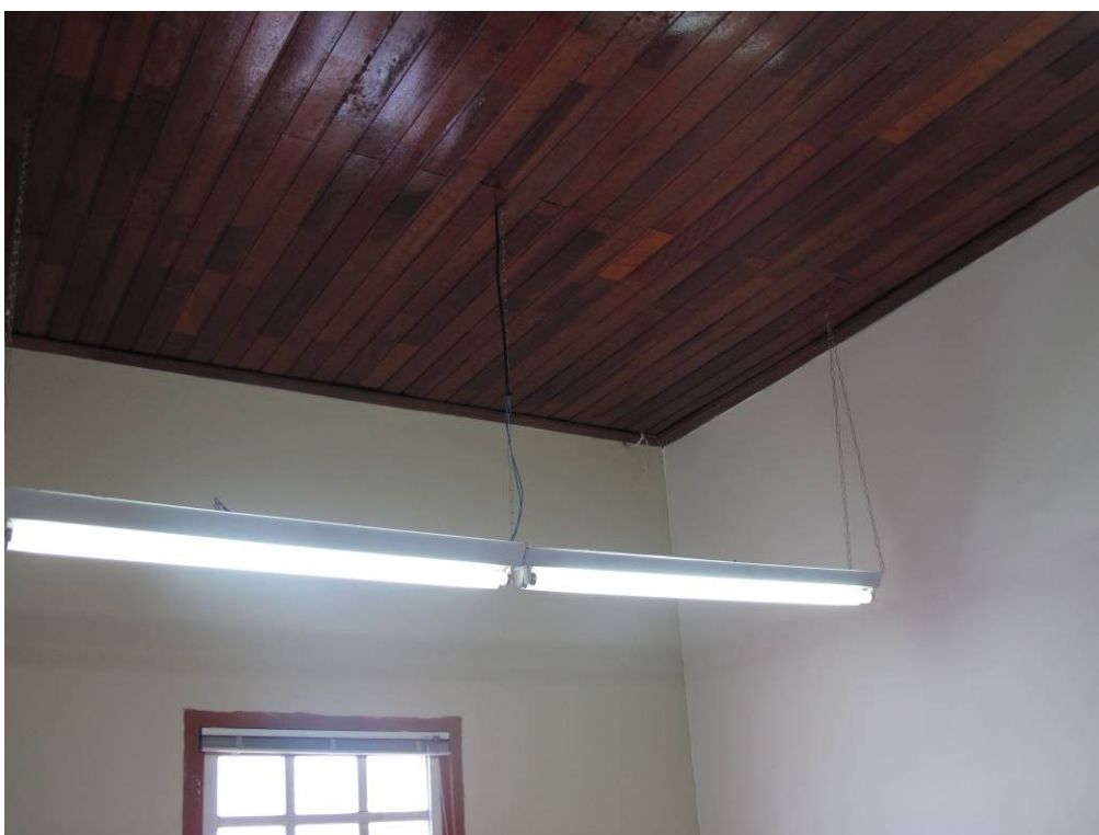
Foto 30 – Forro de madeira e instalação elétrica – bom estado de conservação. Imóvel Rua João Moreira Sales, 37 Data: Dezembro de 2010
